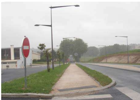
Photo 14 – Aménagement de la RD137 devant le collège
